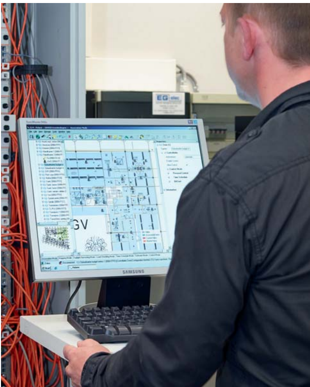
Mise en service du système de gestion d'éclairage.
